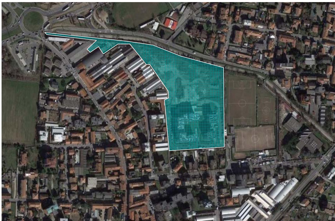
L'area del Programma Integrato di Intervento San Damiano in cui è possibile osservare la parte di intervento già realizzata e riferita al lotto corte sud.
