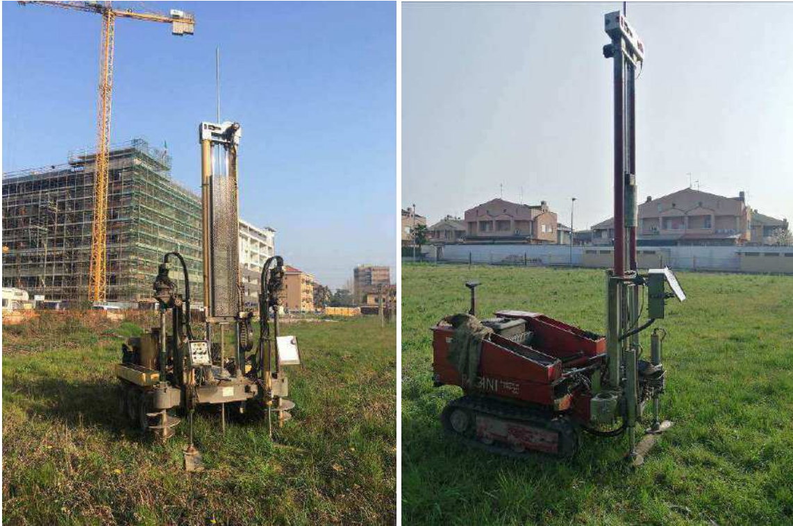
Esecuzione delle prove penetrometriche.
