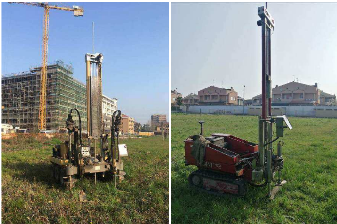
Esecuzione delle prove penetrometriche.
