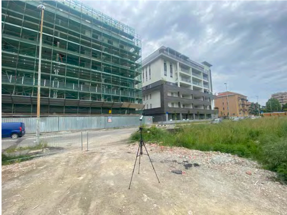
Foto 3: Fonometro posto in PointC, nel terreno su via Garibaldi agli edifici R1 (già realizzato) e R2 (realizzato - in fase di completamento)
