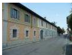
Villa Somaglia, Balconi - complesso Brugherio (MB)
