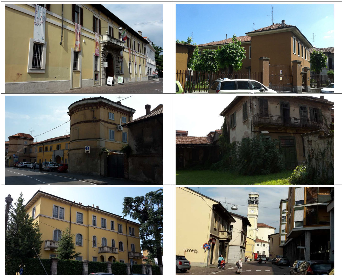
Figura 68 – Immagini relative ai sopralluoghi effettuati per la verifica dei caratteri dei Nuclei di antica formazione
