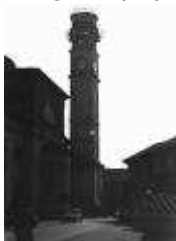
Torre Campanaria di S. Bartolomeo Brugherio (MB)
