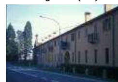
Cascina S. Ambrogio - complesso Brugherio (MB)
